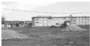
《小高中学校のグラウンド除染》
